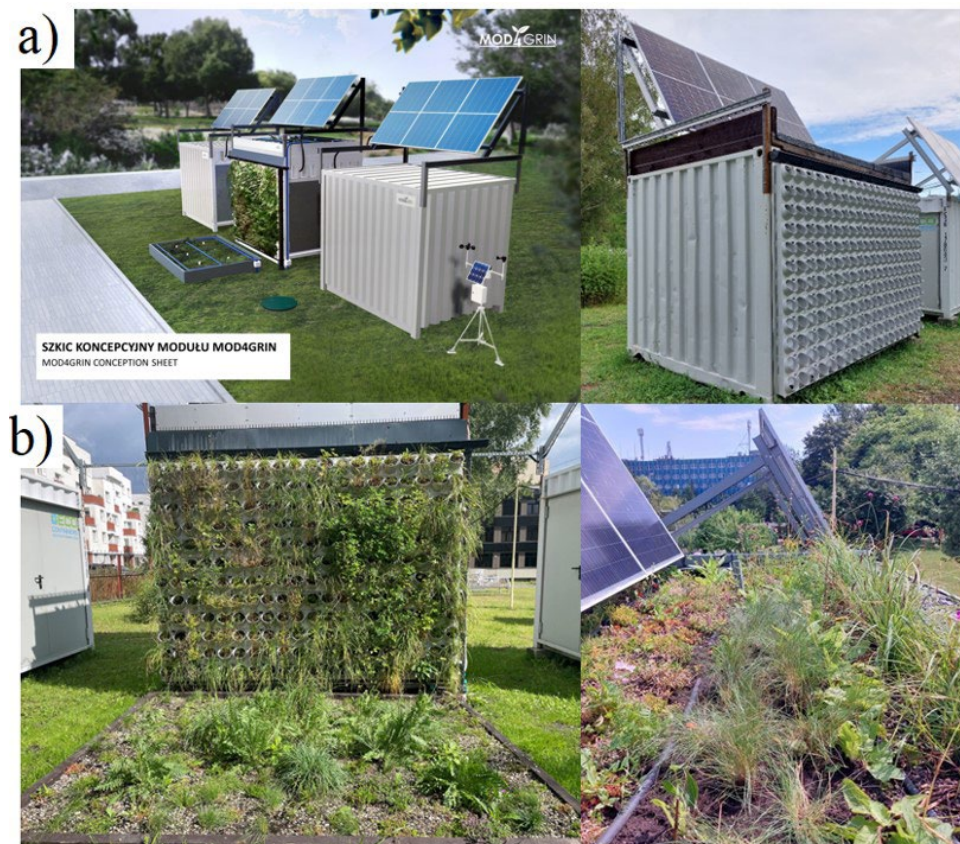
Fot. 3. Schemat koncepcyjny (a) oraz rzeczywista realizacja (b) samowystarczającego zielonego modułu w adaptacji miast do zmian klimatu – projekt Mod4Grin
