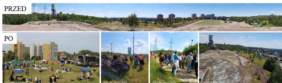
Fot. 1. Ogólny widok Góry Antonia w Rudzie Śląskiej przed i po rewitalizacji
