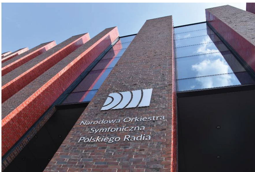
Fot. 2. Siedziba Narodowej Orkiestry Symfonicznej Polskiego Radia w Katowicach
