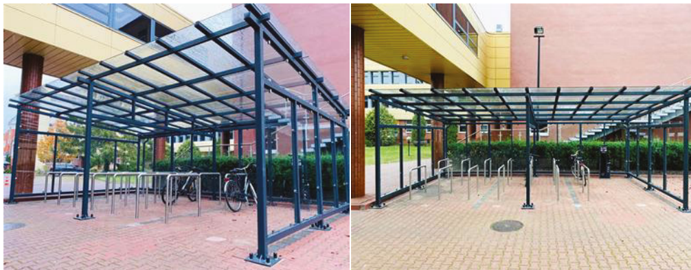
Fot. 17. Wiata rowerowa przy wejściu do Wydziału EkSoc UŁ
