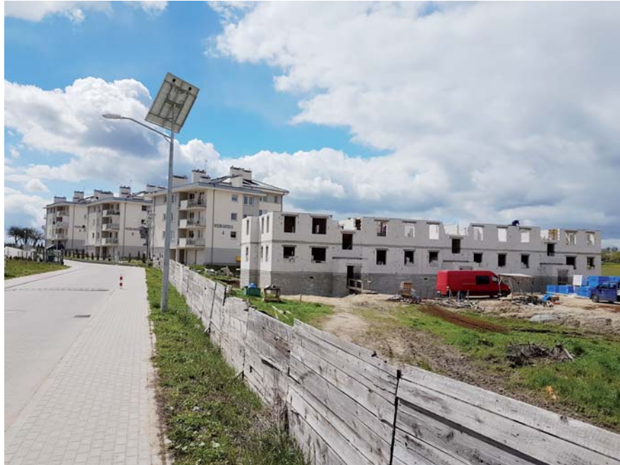
Fot. 3. Olsztynek – budowa nowych domów wielorodzinnych
