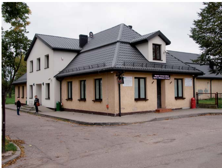
Fot. 16. Dom kultury w Raciążu – nowa inwestycja
