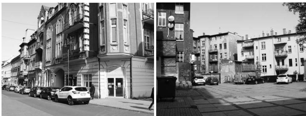
Fotografie 18-19. Zabrze. Widok zewnątrz i wnętrza badanego kwartału zabudowy
