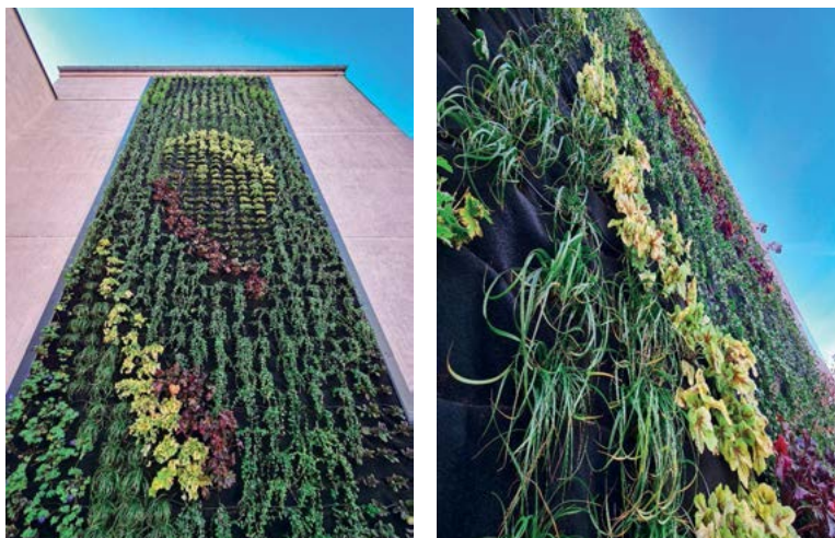
Fot. 5. Ściana budynku ChCK
